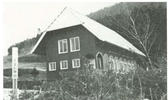
竣工した若里会戸隠山荘(木造二階建延44坪)
