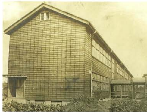
新築された第二校舎 東側より撮影。校舎の中間の渡り廊下は北側の第一校舎につながる。渡り廊下のはるか後方には長野県から移管された旧長野工業試験場の建物の屋根の一部が見える。
