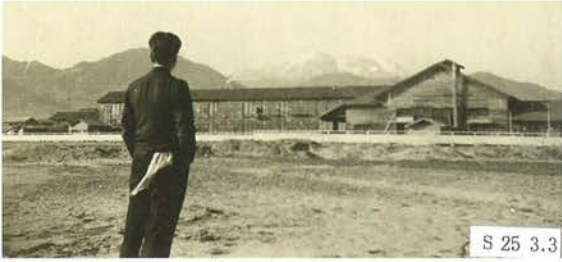
犀川河川敷からの若里寮の全景
