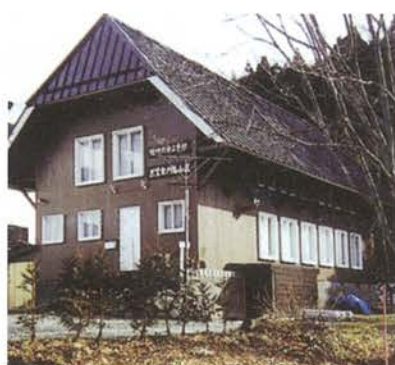
補修を終えた戸隠山荘 (平成 14年)
