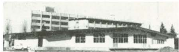
竣工した学生食堂全景
